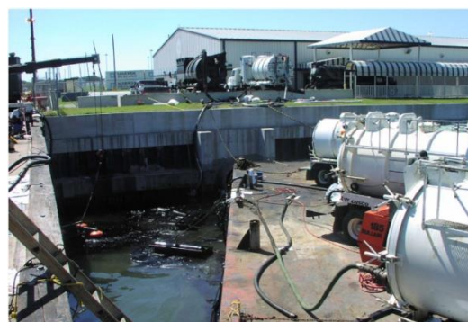
Рисунок П8-19 – Сбор нефти с воды вакуумными установками
