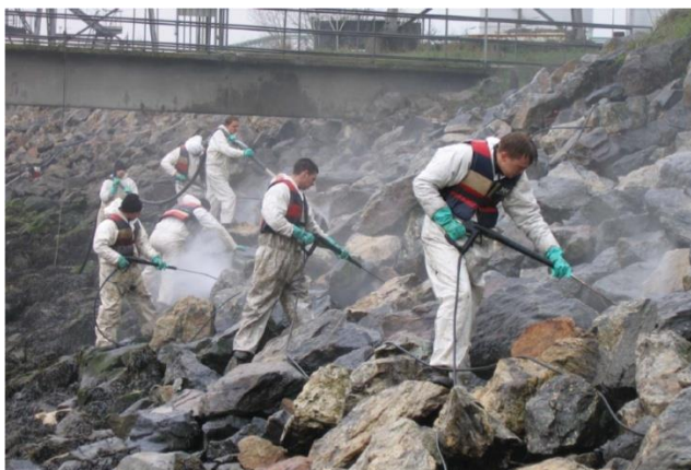
Рисунок П8-23 – Мойка водой под напором
